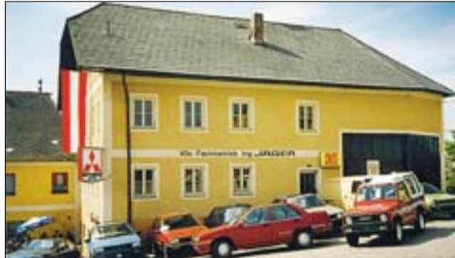
1848 errichtet Franz Jäger in Niederkappel eine Schmiede
